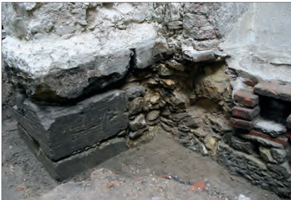
Obr. 11: Praha-Malá Strana, čp. 28/III. Dnešní pilíř na východní straně rajského dvora stojí na gotickém armovaném pilíři a zachovává jeho půdorys (foto M. Müller, 2007).
