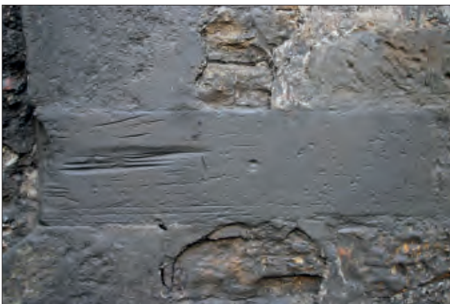
Obr. 6: Praha-Malá Strana, dvůr mezi čp. 28 a 33/III. Na jednom z kamenů nárožního opěráku (K 7) jsou stopy interpretované jako vrypy po broušení nožů (foto M. Müller, 2007).
