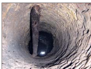
Obr. 9. Vnitřek studny po odstranění cihlové zazdívky (foto T. Cymbalak, 2008).
