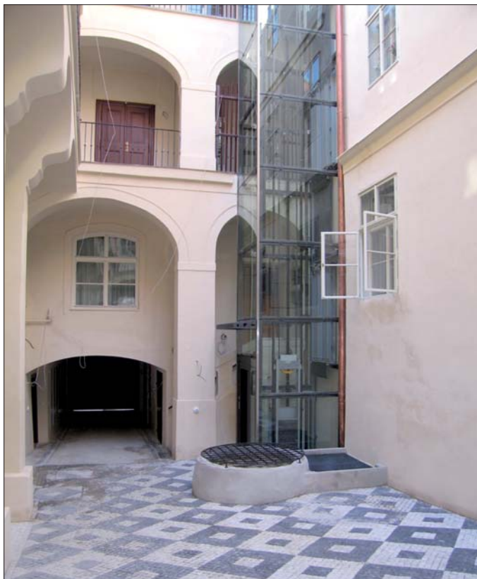
Obr. 17. Prostorová prezentace nově odkryté studny ve dvoře domu čp. 260/III – pohled k jihu, k ulici Tržiště (foto SPELEO – Řehák, 2008).
