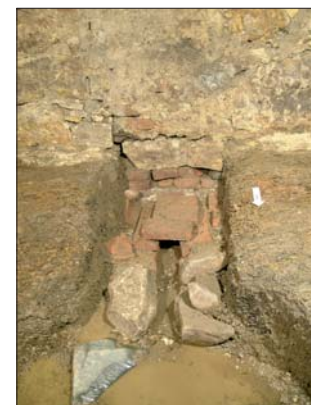
Obr. 7. Detail ústí kanálků u jižní stěny spodního sklepa. Stav před odstraněním zadržívky (foto E. Ditmar, 2007).
