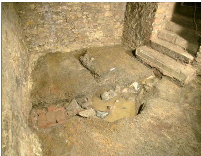
Obr. 2. Stav odvodňovacího kanálku ve spodním sklepe domu (jaro 2007). V pravém horním rohu patrně přístupové schodiště vystavené z druhotně použitých barokních (?) ostění. Pohled od východu (foto E. Ditmar, 2007).
