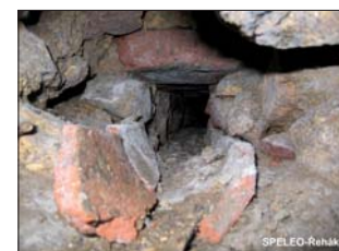
Obr. 11. Detail ústí cihlového odvodňovacího kanálku ve studni (foto SPELEO – Řehák, 2008).
